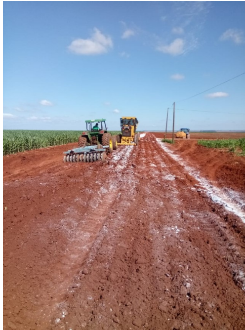
Figura 3: Incorporação do produto na camada de 20 cm
