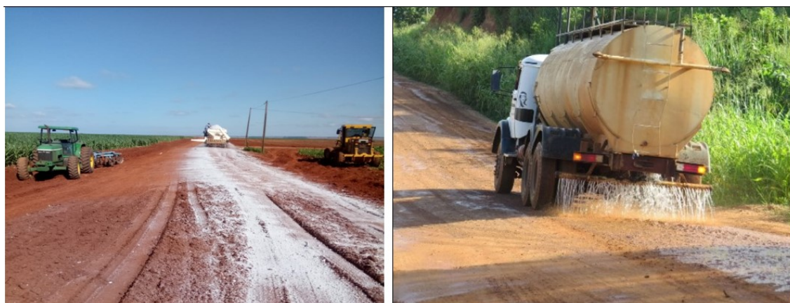
Figura 2: Exemplo de distribuição/aplicação do estabilizando sólido e líquido
